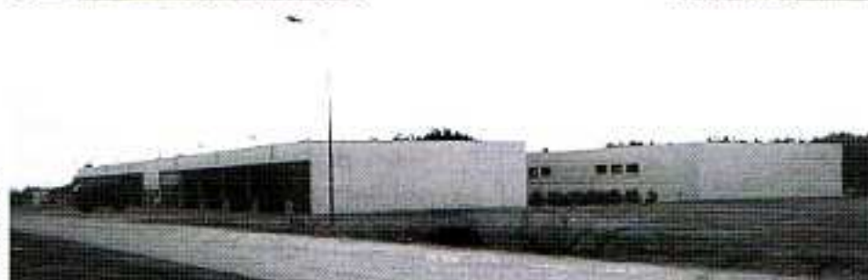
Aus dem ehemaligen, unbewohnbaren Barackenlager in Großmittel wurde durch zahlreiche Neubauten und Renovierung alter Objekte die heutige Jansa-Kaserne, die den Anforderungen mechanisierter Kräfte voll entspricht.
